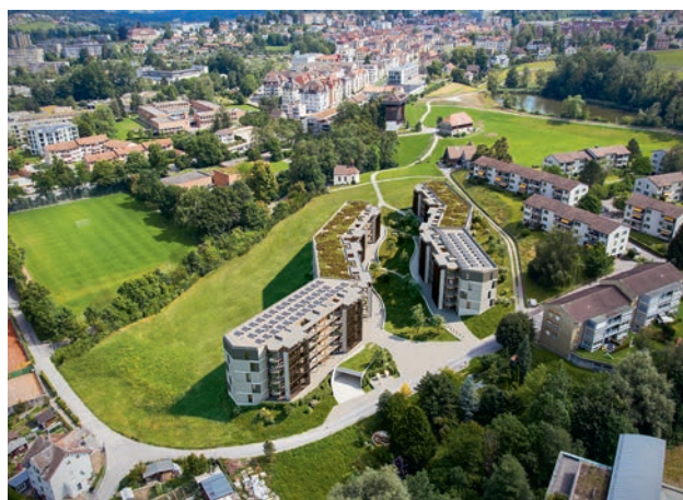
Lotissement « Waldacker », à Saint-Gall, avec 110 appartements © B-VR Switzerland
